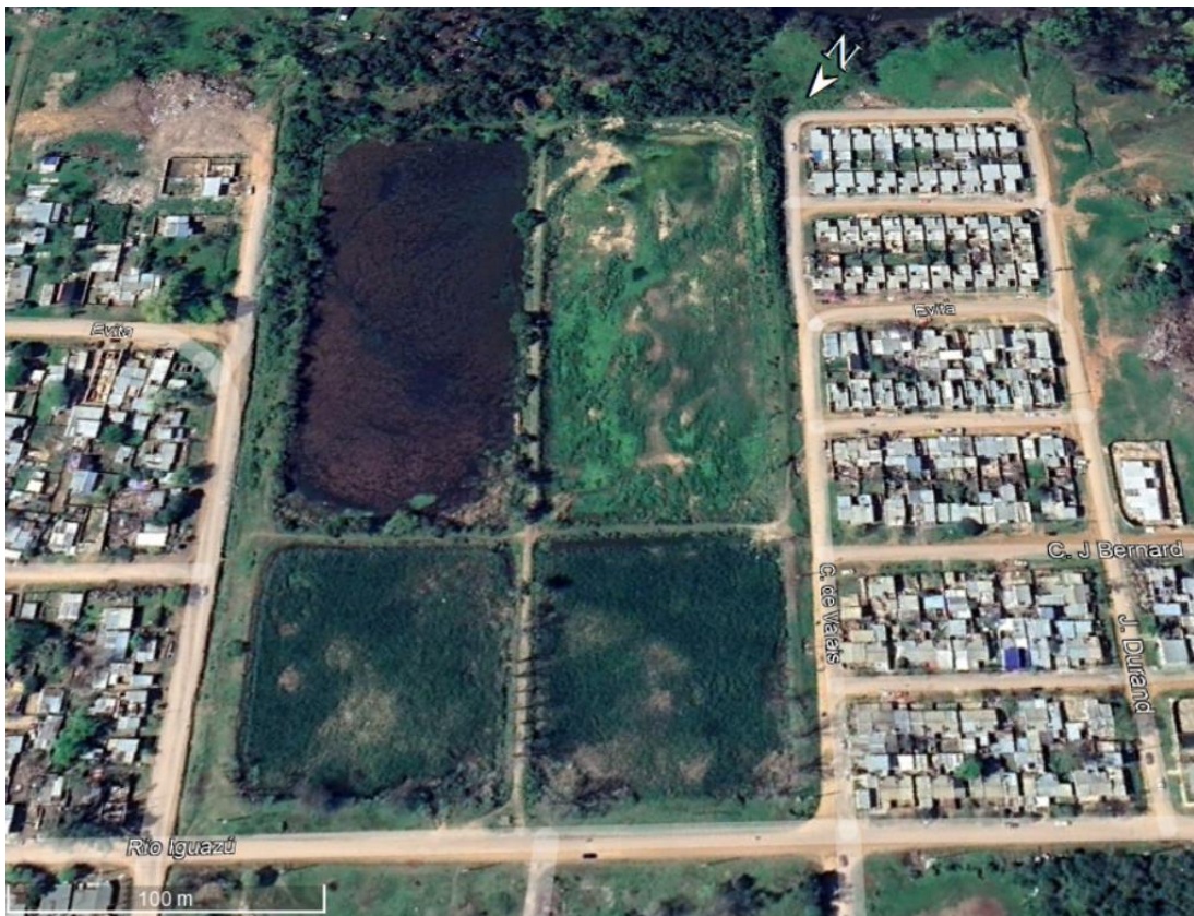
Figura 6 Imagen satelital (Google Earth) de lagunas anaeróbicas (abajo) y facultativas (arriba).
